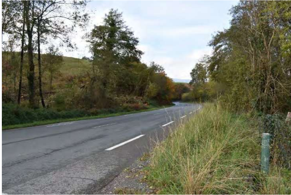
Figure 7 : Vue vers l'Ouest depuis la sortie du site (ENCEM, Novembre 2022)
