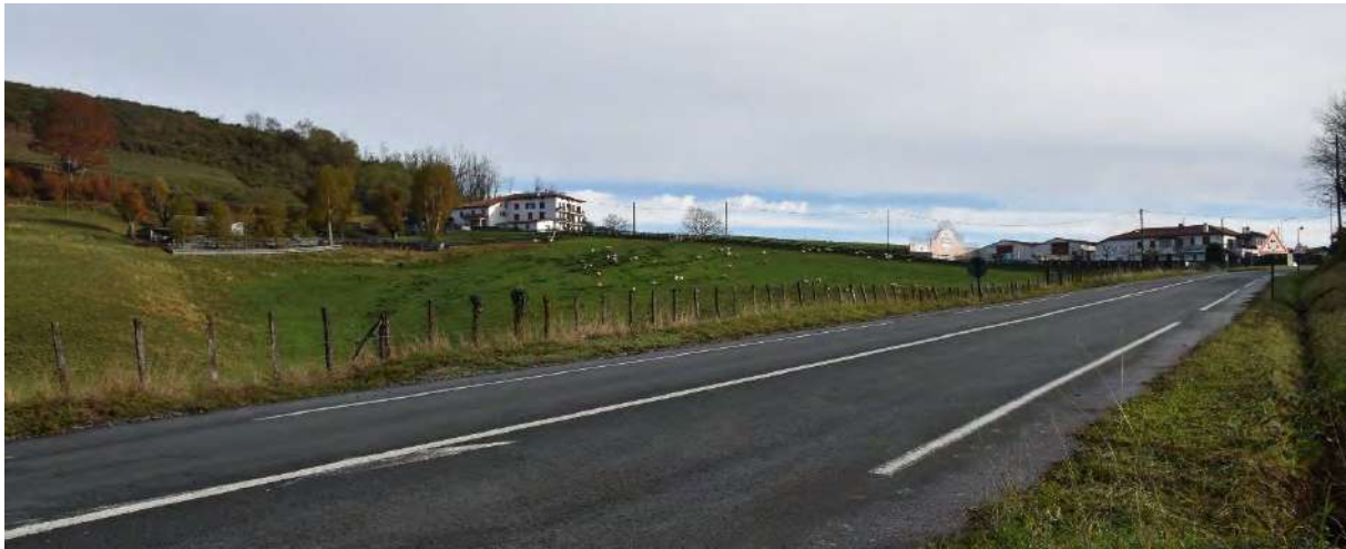
Figure 30 : Photographie de la clôture en place en bordure de la RD 918 (ENCEM)
